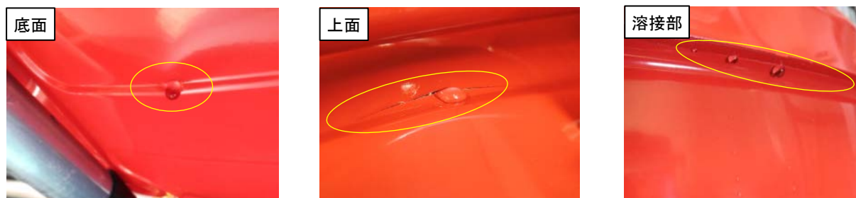
写真5. 表面や溶接部の亀裂から水が漏れいする様子
